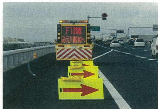
後尾警戒標識設置状況 標識車による迂回推奨状況(みえ川越)
