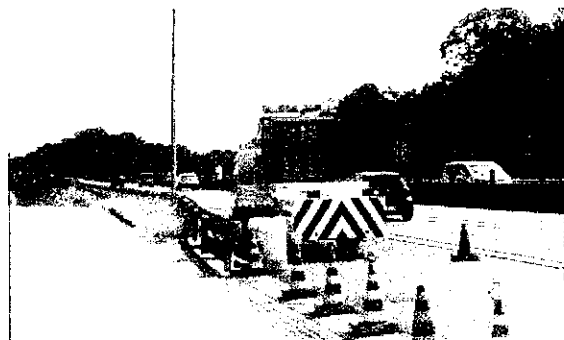
後尾警戒車による注意喚起状況 (亀山JCT)
